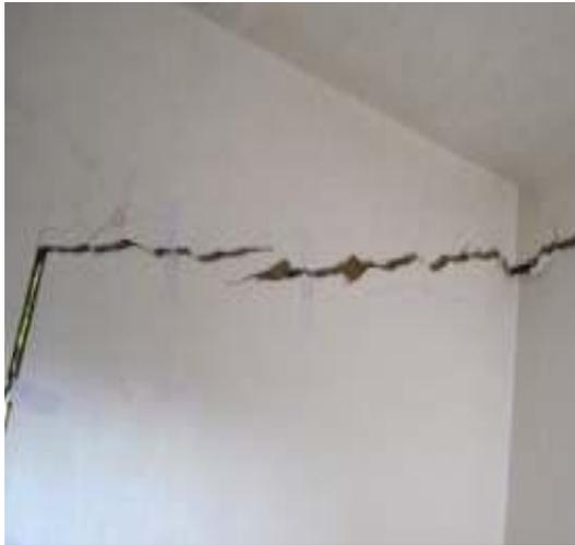
2) 柱构件水平裂缝
