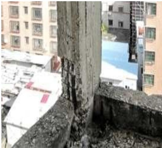
4) 梁钢筋锈蚀、保护层脱落
