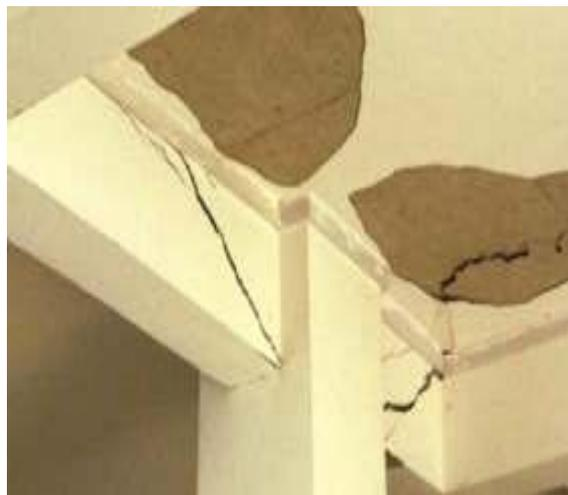
5) 柱受剪裂缝
