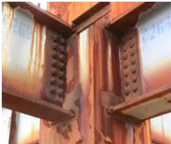
3) 柱钢筋锈蚀、保护层脱落
