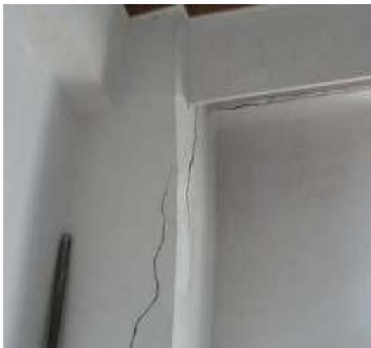
4) 梁构件端部斜向裂缝
