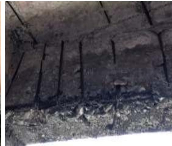
5) 板钢筋锈蚀、保护层脱落
